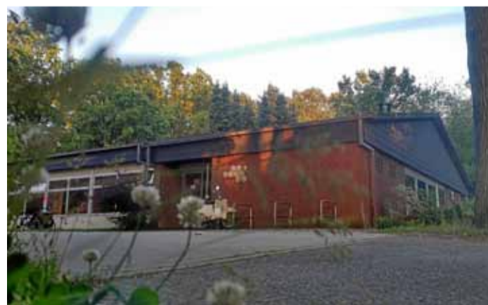
Das Dorfgemeinschaftshaus in Soderstorf ist in die Jahre gekommen. Vor allem die Gebäudetechnik soll nun umfassend saniert werden.
